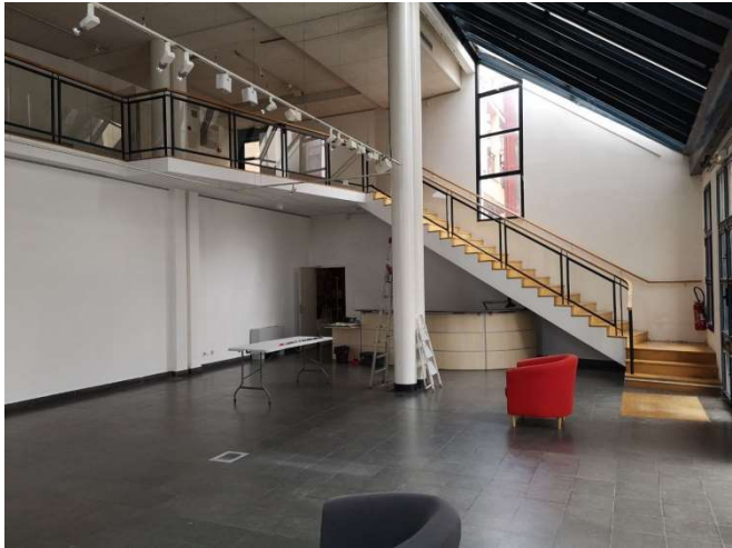
Vue escalier droit
