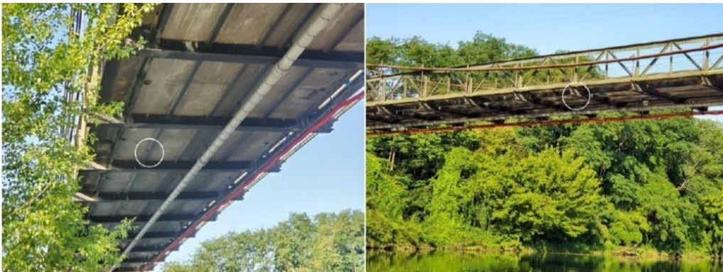
Localisation des nids d'hirondelles sous l'ouvrage (rapport LPO Occitanie - 2023)
